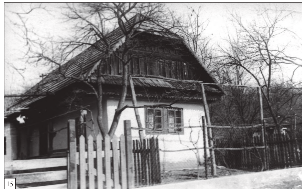
Фото 14. Типова зрубна хата малоземельного землероба села, споруджена за часів Чехословаччини – галерея тільки з боку подвір'я. Хату дав спорудити Василь Желізник 1922 р. Хату успадкувала його дочка – дружина Олесінь Петра. Хата нині (1977 р.) в побуті.
